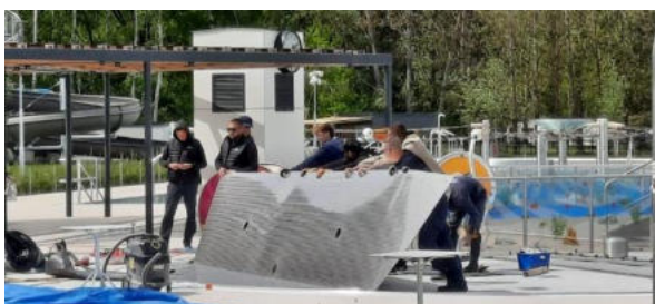
oprava vodních clon
