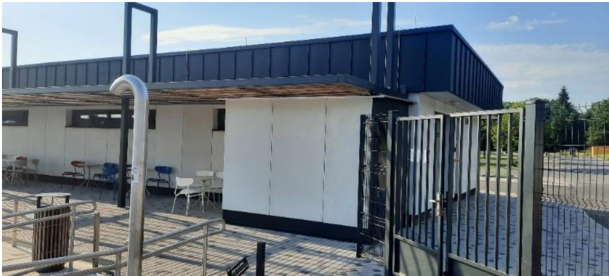
výstavba skladu pro úklidové stroje
